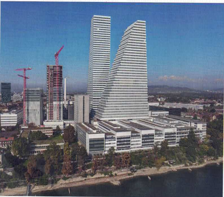
Das Pharmaunternehmen Roche erweitert seinen Hauptstandort in Basel in der Schweiz
